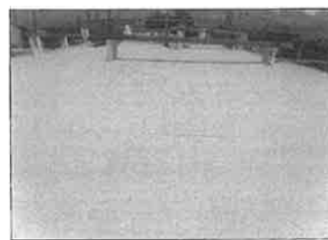
รูปที่ 16. Roof Sheet พบสีเสื่อมสภาพ เป็นฝุ่น ลูบติดมือ ไม่พบความเสียหายที่รุนแรง
