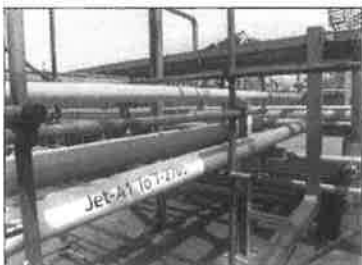
รูปที่ 24. ระบบท่อรอบถัง พบสีเสื่อมสภาพ และหลุดร่อนเล็กน้อย ไม่พบความเสียหายที่รุนแรง
