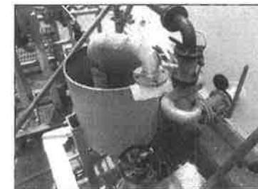
รูปที่ 12. Product drain พบสนิมที่ครั้นเหล็กโดยบริเวณ Bolts & Nuts ไม่พบความเสียหายที่รุนแรง
