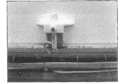
รูปที่ 5 Anchor Chair/Anchor Bolt พบใช้ส้อมสวมทาบ เป็นปูน ตูมติดมีรื้อ ไม่พบความเสียหายที่รุนแรง
