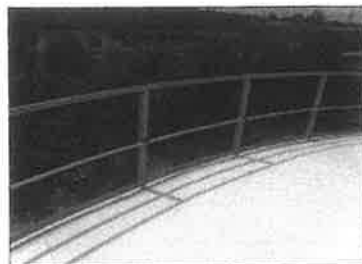
รูปที่ 15. Roof Handrail พบสีเสื่อมสภาพและหลุดลอกเล็กน้อย ไม่พบความเสียหายที่รุนแรง
