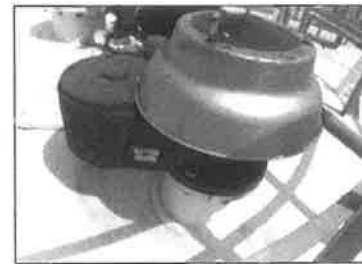
รูปที่ 18. Breather Valve พบสนิมที่คอวาล์วและบริเวณ Flange และ Bolts & Nuts ไม่พบความเสียหายที่รุนแรง
