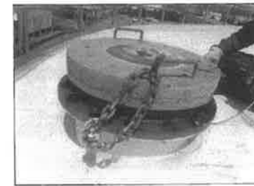
รูปที่ 20. Emergency Valve พบสีเสื่อมสภาพและสนิมเล็กน้อย ไม่พบความเสียหายที่รุนแรง
