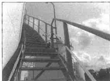
รูปที่ 14. Stairway และราวบันไดอยู่ในสภาพดี
