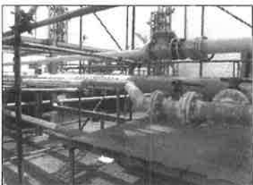
รูปที่ 24. ระบบท่อรอบถัง พบสีเสื่อมสภาพ และหลุดร่อนเล็กน้อย ไม่พบความเสียหายที่รุนแรง
