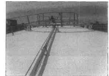
รูปที่ 25. ระบบท่อน้ำกับเพิงรอบถังและถัง พบสีเสื่อมสภาพ เป็นจุดๆ ขึ้นฉีดยึดไม่พบความเสียหายที่รุนแรง
