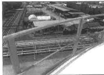
รูปที่ 15. Roof Handrail พบสีเสื่อมสภาพและหลุดลอกเล็กน้อย ไม่พบความเสียหายที่รุนแรง
