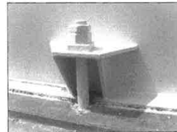
รูปที่ 5 Anchor Chair/Anchor Bolt พบใช้ส้อมสวมทาบ เป็นปูน ตูมติดมีรื้อ ไม่พบความเสียหายที่รุนแรง
